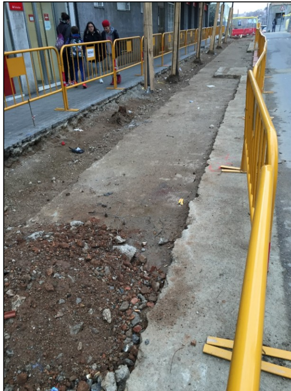
Fig. 27. Rasa 18, que respon a l'obertura de la part est del carrer Mare de Déu de Lorda. Com s'aprecia només s'extreu l'asfalt.
