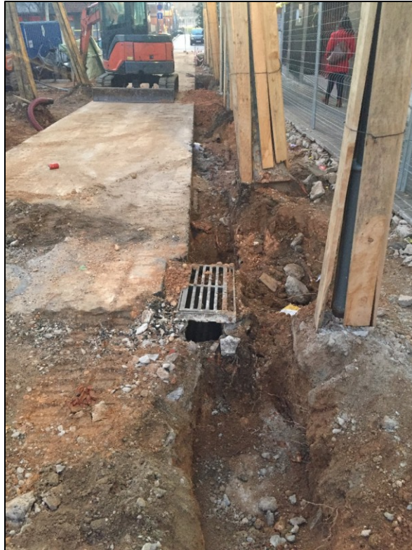
Fig. 18. Rasa 10, seguint el carrer de la Madriguera, en tota l'allargada de la plaça. També s'aprecia la llosa de formigó central.
