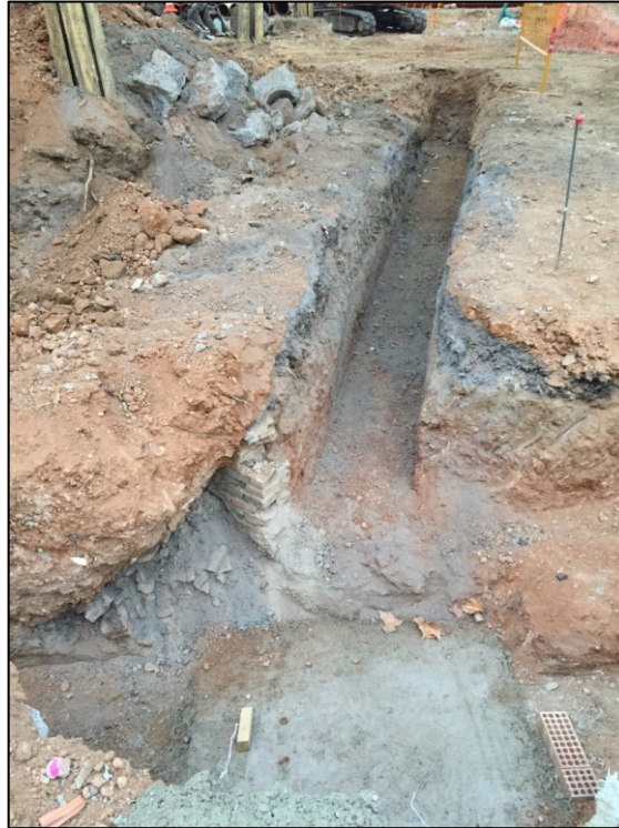
Fig. 5. Rasa 2 en direcció oest-est. A l'esquerra de la rasa s'aprecia el mur (UE 24) i l'enderroc associat (UE 25) trencat en una reforma precedent.
