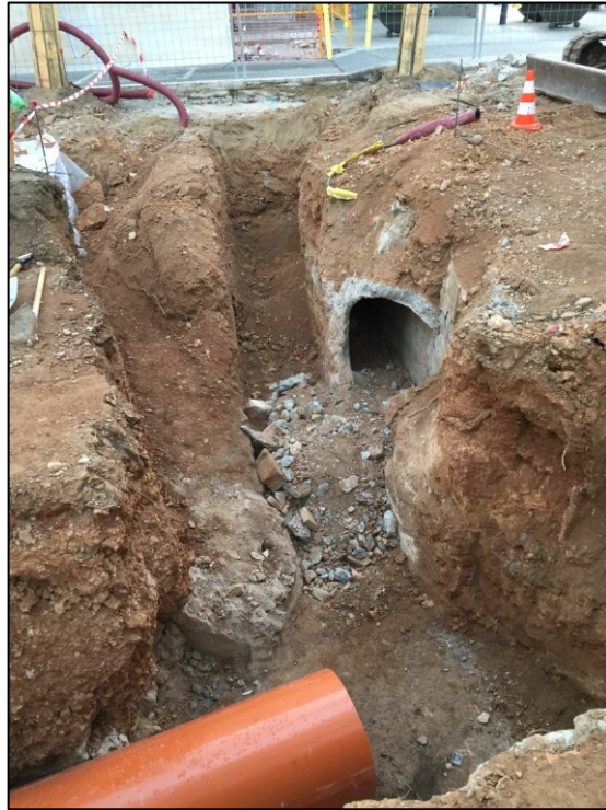
Fig. 13. Rasa 8, en direcció carrer Mare de Déu de Llorda, paral·lela a l'antic col·lector de la plaça. Al costat esquerre es pot apreciar l'estructura (UE 27), arrasada en reformes precedents.
