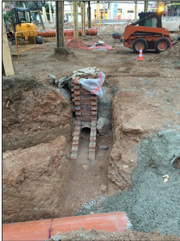
Fig. 7. Rasa 4 en direcció oest-est. En aquest cas ja amb l'embornal construït.
