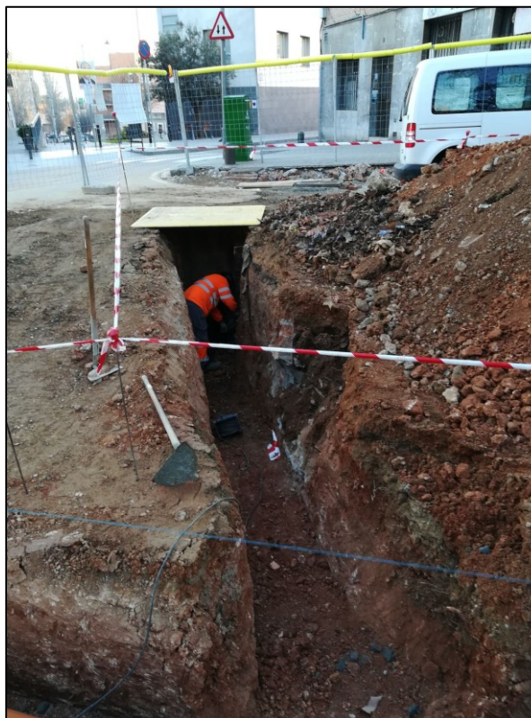
Fig. 28. Rasa 19, prolongació de la rasa 1 en direcció la cruïlla entre els carrer Madriguera i Mare de Déu de Lorda.
