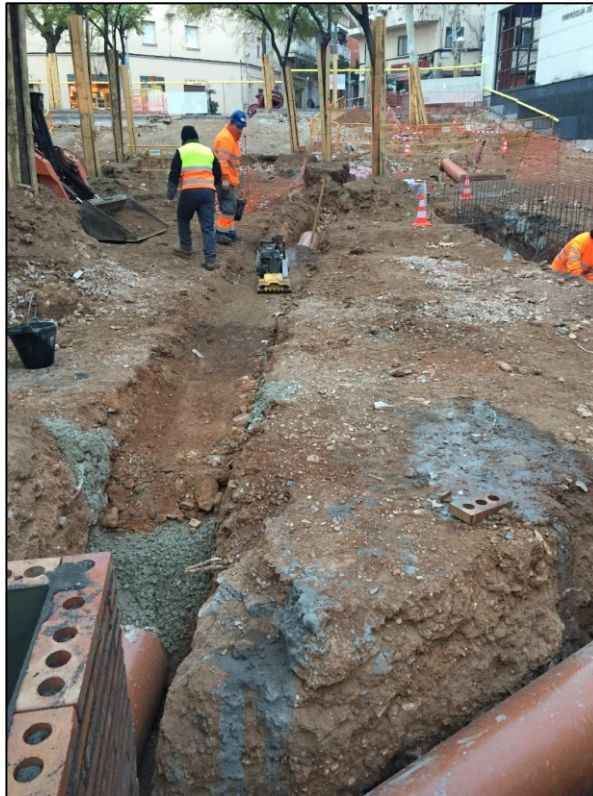
Fig. 9. Rassa 5 vista des de l'est, un cop ja s'ha instal·lat el desaigua.
