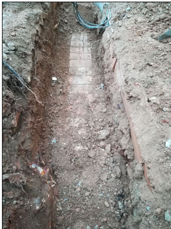
Fig. 22. Rasa 13, en la zona central, on es localitza una solera (UE 29), base de la canalització precedent.
