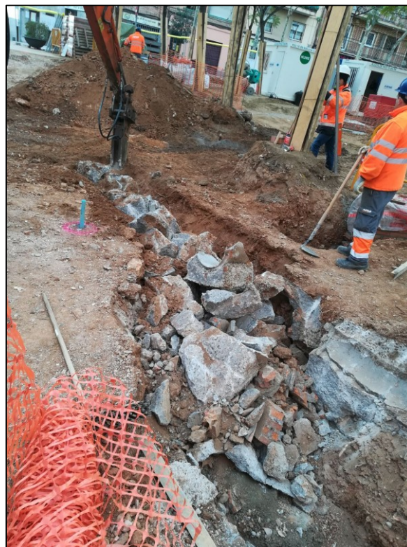
Fig. 4. Prolongació de la rasa 1 en direcció oest, substituint una estructura precedent.
