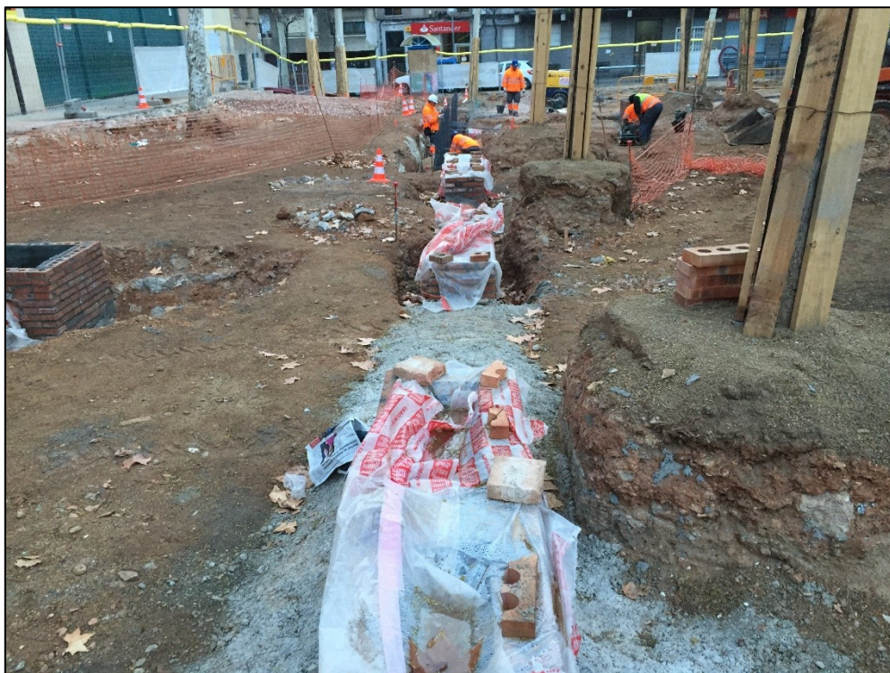
Fig. 24. Rasa 15, prolongació cap a l'oest de la rasa 6. En relació a elements elèctrics.
