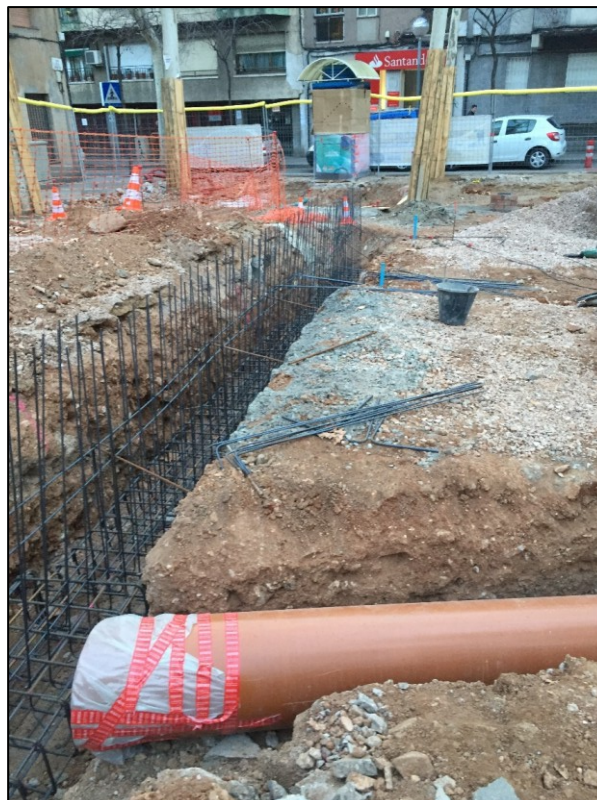
Fig. 10. Rassa 6 un cop iniciat el forjat de l'encofrat del mur. També s'aprecia l'inici de la rasa 1.
